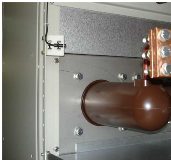
slika 2. Optička sonda OS montirana u sklopnom bloku
